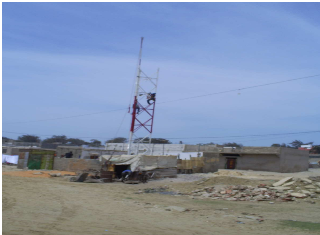
Figure 3 Les travaux d'extension de la couverture téléphonique à Guêt-Ndar (Saint-Louis)
